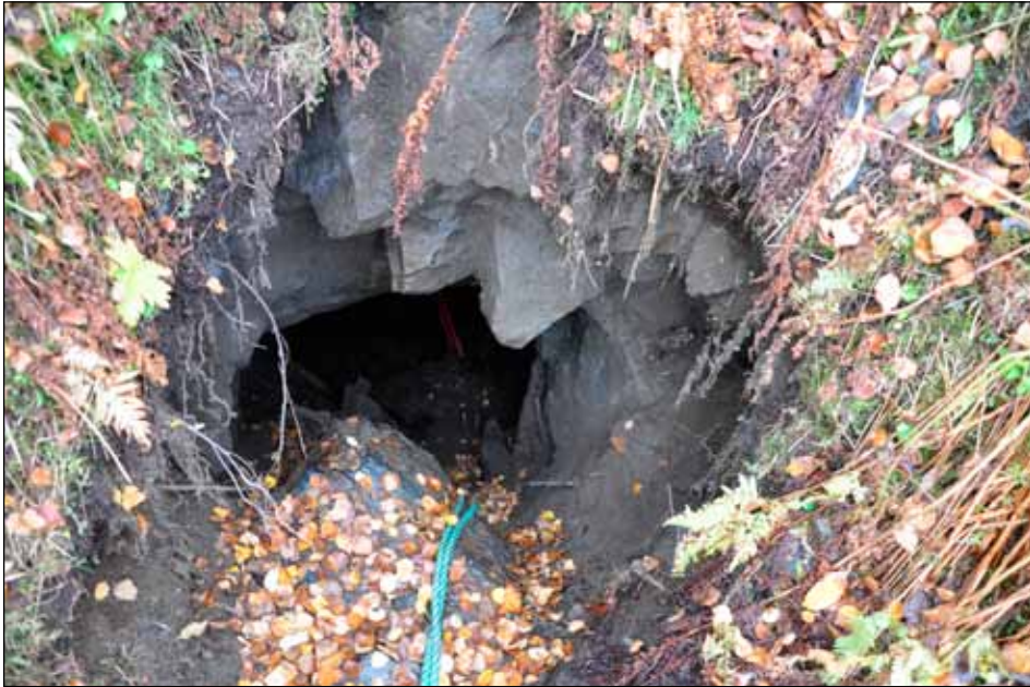
Tunnelåpningen. Foto: Bård Andreassen.
